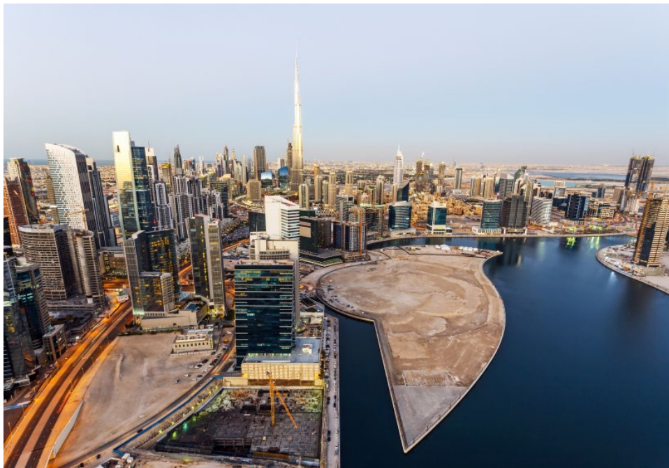
Dubai setzt nach den Turbulenzen auf dem Immobilienmarkt auf ein breiter angelegtes Wachstum.
